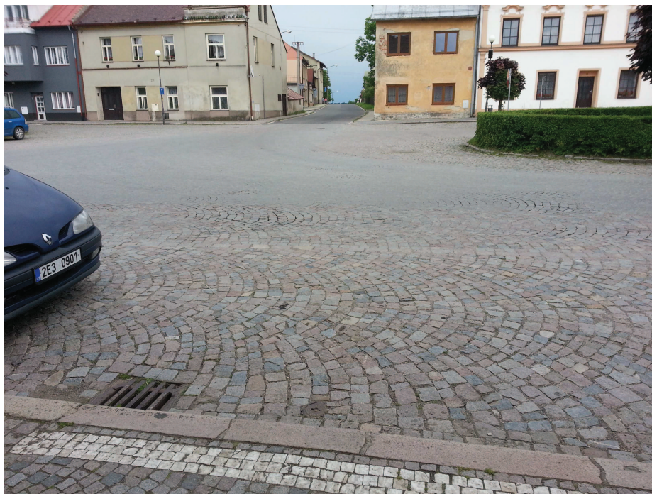
Foto: v místě navrhovaného přechodu pro chodce
